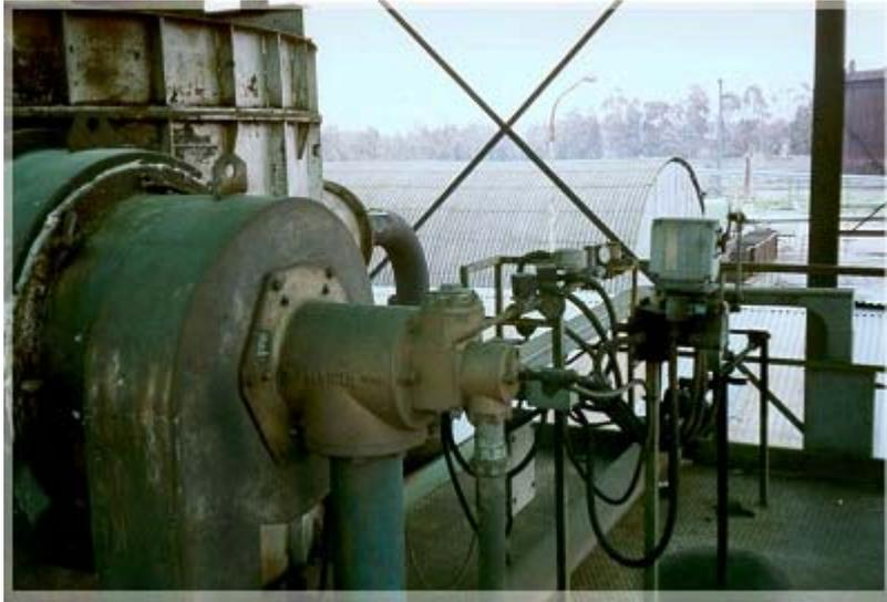
Figure 8. Camera di combustione: bruciatore
